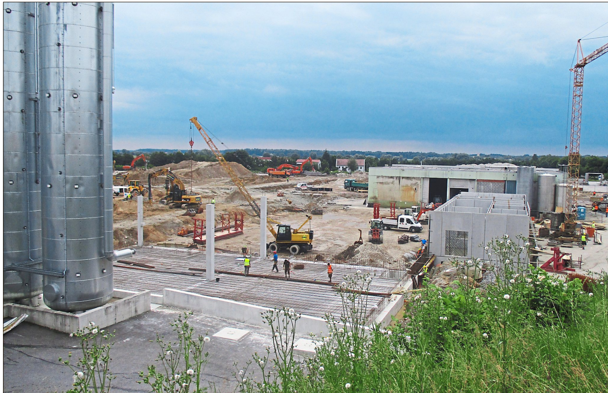
Großbaustelle Wiesenhof Bogen. Schon zu Jahresbeginn 2016 soll der Schlachtbetrieb wieder anlaufen. (Foto: stu)
