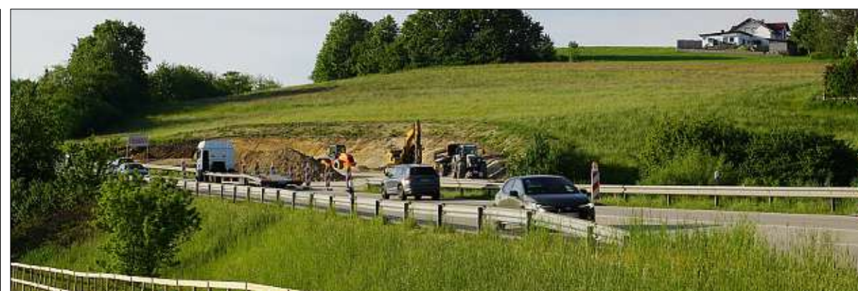
Die Baufirma hat bereits damit begonnen, eine 130 Meter lange Baustellenumfahrung zu bauen.
